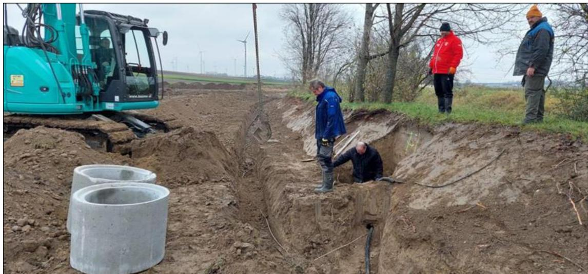
In den Wintermonaten erfolgten Arbeiten für den Brunnenbau sowie Verkabelung und Fundamente der Flutlichtmasten. Allen Helfern gebührt ein herzliches Dankeschön.
