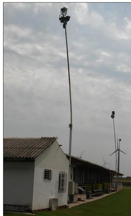
Zwei Flutlichtmasten wurden verbogen. Nach genauer Bestandsaufnahme war kein sofortiger Austausch erforderlich.
