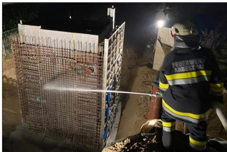
Baustelle eine Schalung einer zu betonierenden Stahlbetonwand gebrochen war und eine sehr große Menge an Beton ausgelaufen war. Der Beton wurde mit Hilfe der Feuerwehr mit Wasser verdünnt, um von der vor Ort tätigen Firma abgepumpt werden zu können, bevor er erhärtet. Die Feuerwehr war hierbei neun Stunden im Einsatz.
